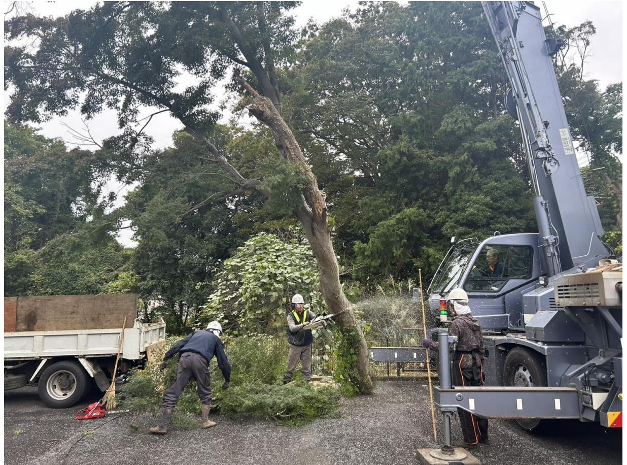
神奈川県座間市入谷付近の線路において、線路内の支障木を伐採いたしました。当初線路沿いから発生材を搬出する計画でしたが、地元の建設会社様より隣接している駐車場をお貸し頂けたので、クレーンを用いた安全な作業を行うことができました。
