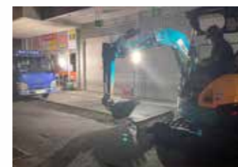
夜間舗装工事
