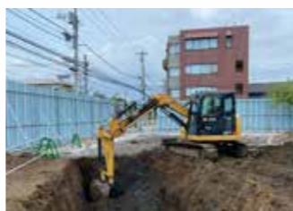
雨水貯留管整備
