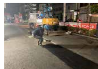
夜間舗装工事
